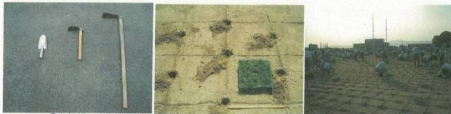
②移植鍬、小鍬(地面が硬ければ唐鍬)で深さ5cm程度の穴を掘る
